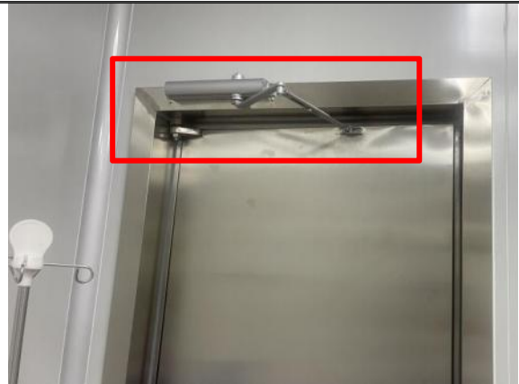
图 3-9 污洗间出入机房防护门自动闭门装置
