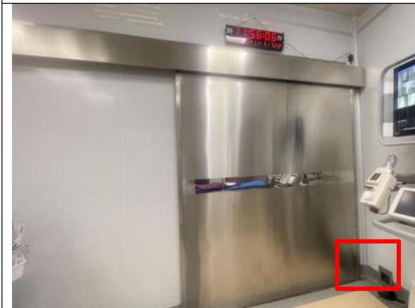
图 3-5 病人出入机房防护门脚感应装置
