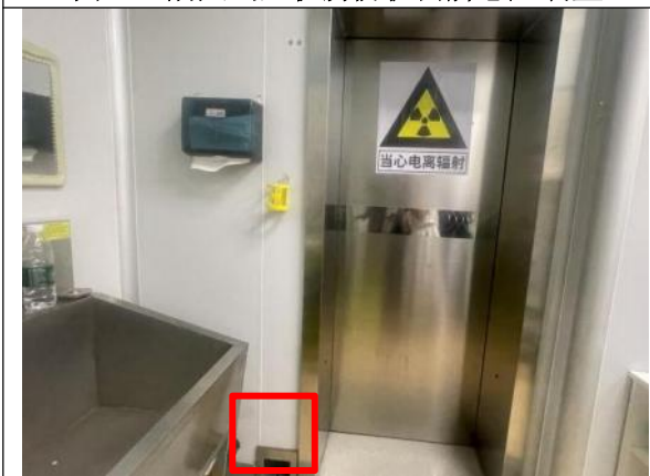
图 3-7 控制室出入机房防护门脚感应装置
