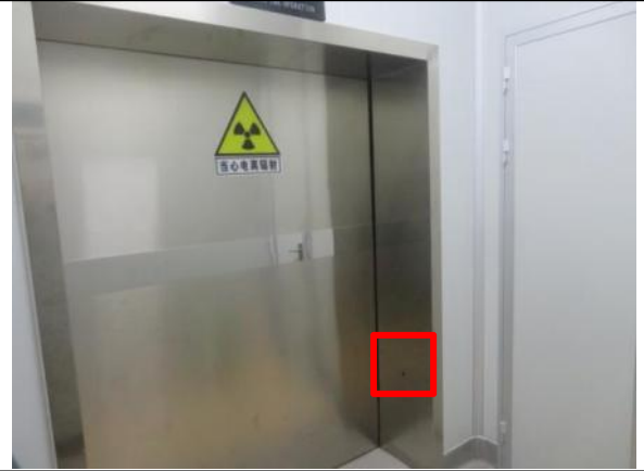
图 3-4 病人出入机房防护门红外防夹人装置
