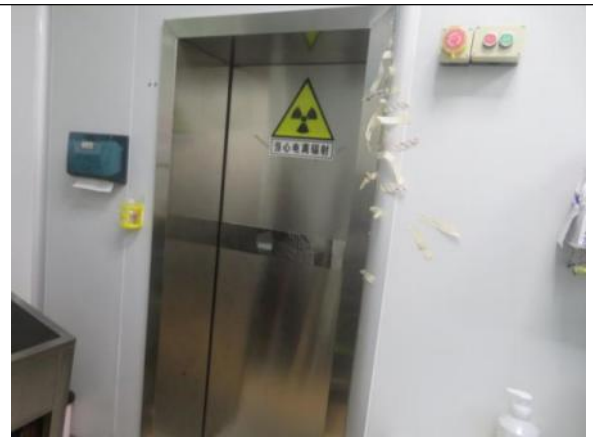
图 3-6 控制室出入机房防护门
